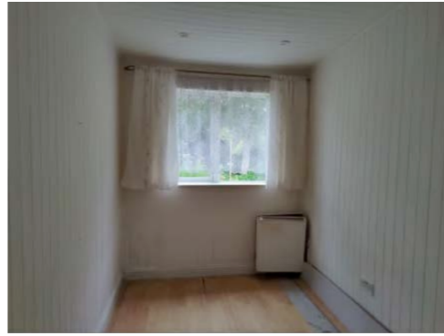
2001_No 13_Room 144_IMG20240712112733.jpg
