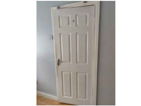
2001_No 13_Room 142_IMG20240712112704.jpg
